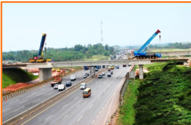
Penyelesaian simpang susun to KM 34,7
